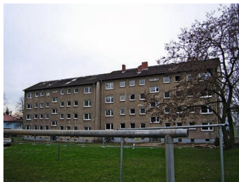
Außenansicht vor der Sanierung
