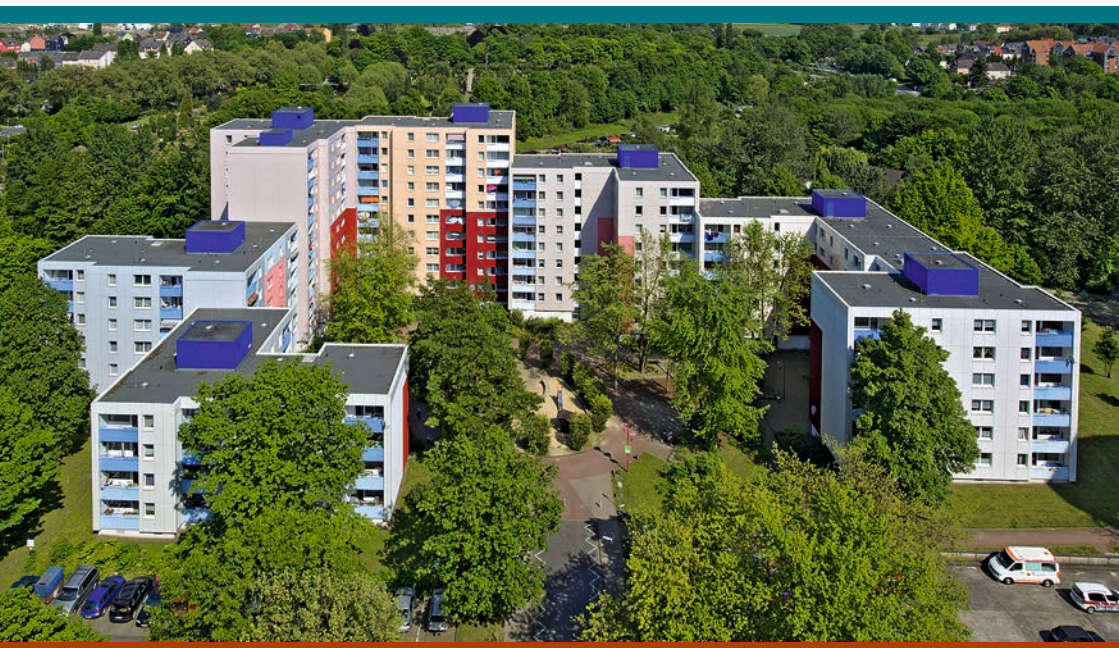
Luftaufnahme Clarenberg · Foto: LEG Immobilien AG
