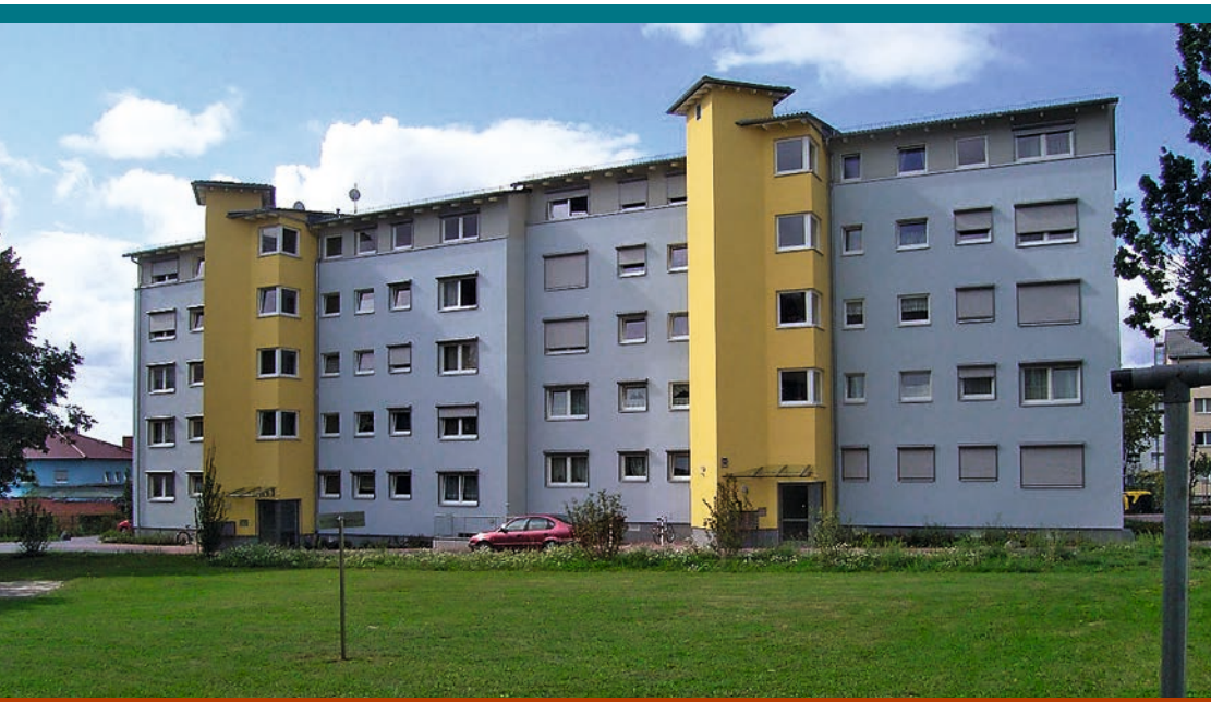
Außenansicht nach der Sanierung
