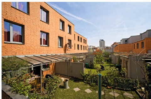
Nähe durch Sichtbeziehungen und Distanz durch Abgrenzungen der privaten Bereiche
