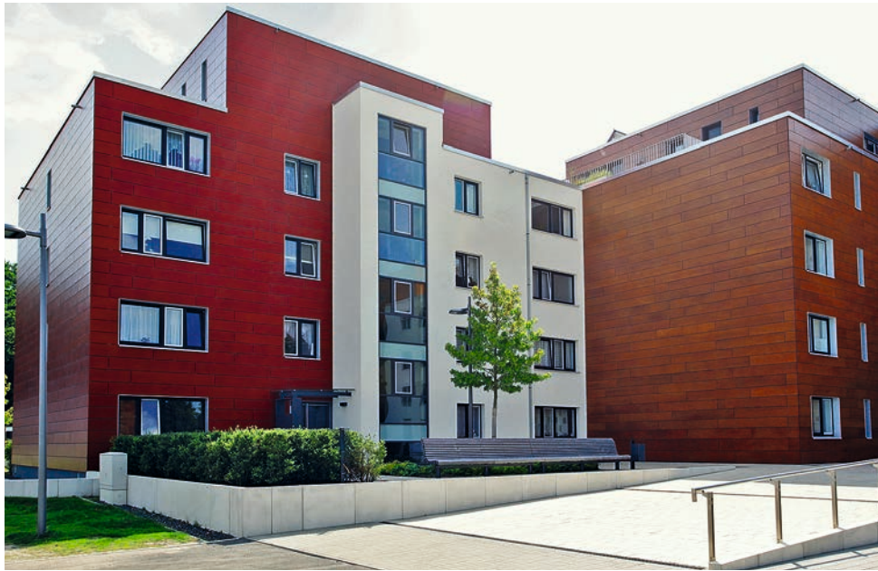
Nach dem Rückbau barrierefrei gestaltete Eingangsbereiche · Foto: Neuland
