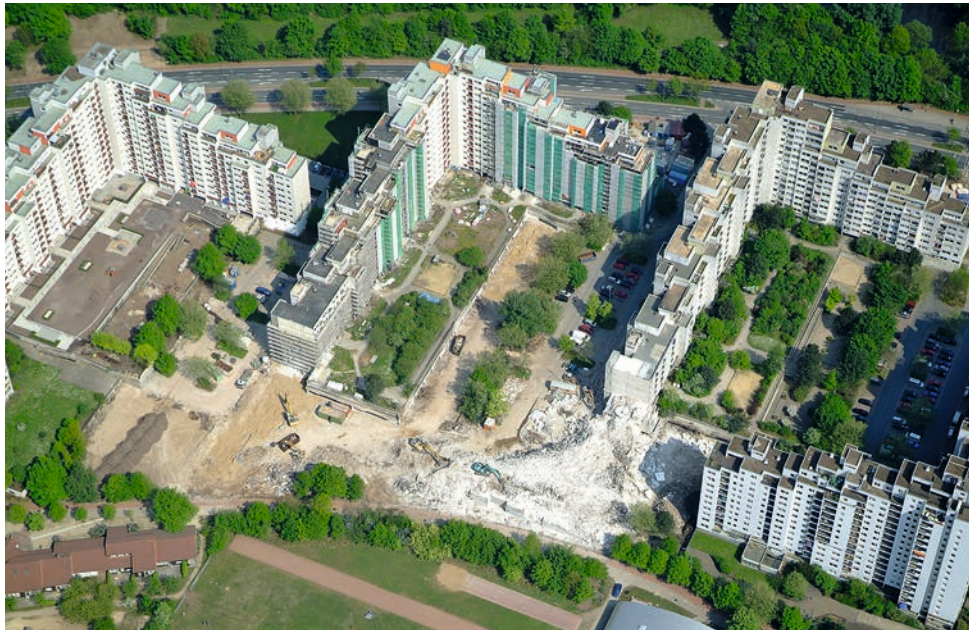
Luftaufnahme während des Rückbaus; Chancen für die Freiraumgestaltung
