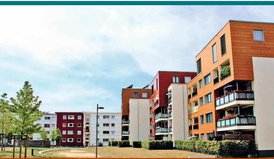
Die Neue Burg nach dem Rückbau und der Sanierung · Foto: Neuland
