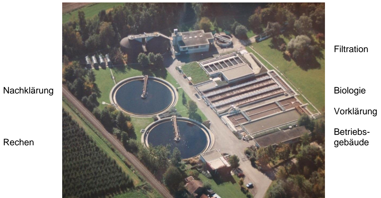
Abb. 26: Kläranlage Eriskirch / Reinigungsstufen – Einrichtungen
