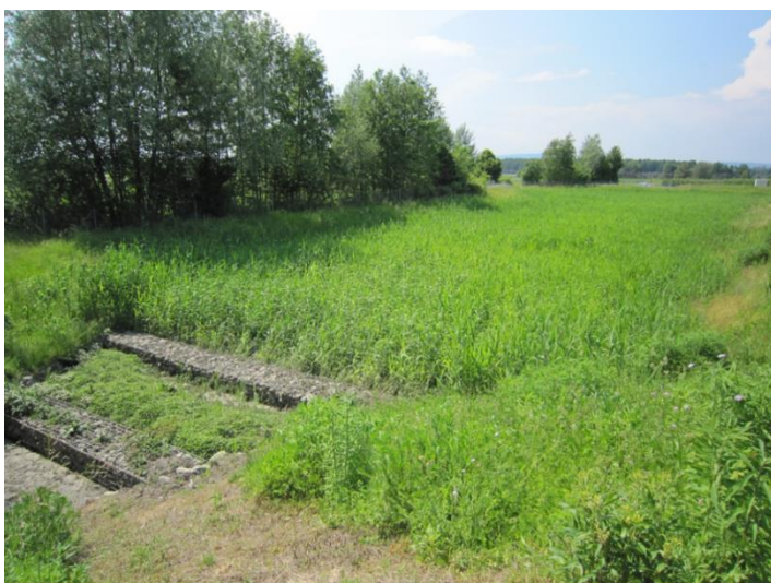
Abb. 47: Retentionsbodenfilter (RBF) Tettngang 2002 / 2013
