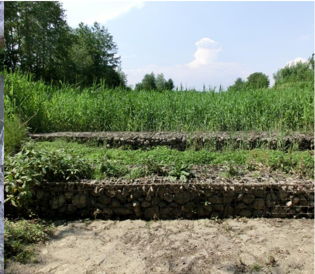
RBF Einlaufschwelle Zulaufseite
