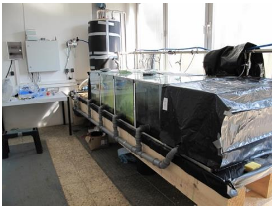
Abb. 8: Bypass-Anlage an der Schussen unterhalb der KA Langwiese
