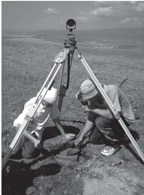
Abb. 12 Betonieren eines Rasterpunktes mit exakter Lage (Christian Hartmann).
