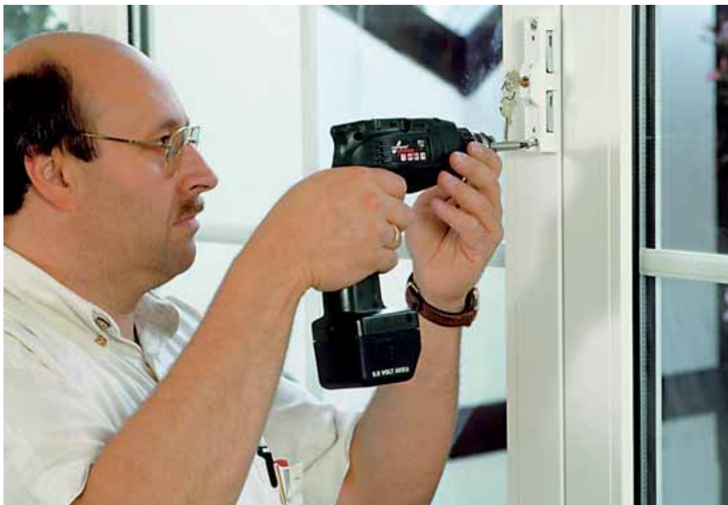
Einbau zusätzlicher Fenstersicherungen.
