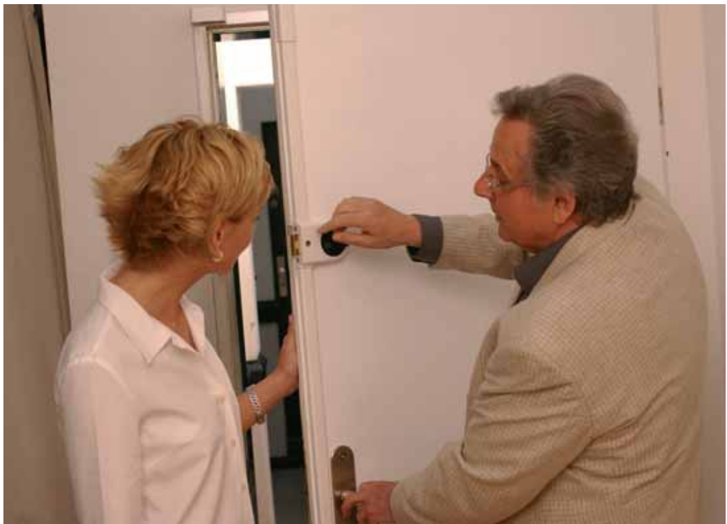
Experten beraten die Mieter beim Einbau von Sicherungsmaßnahmen.
