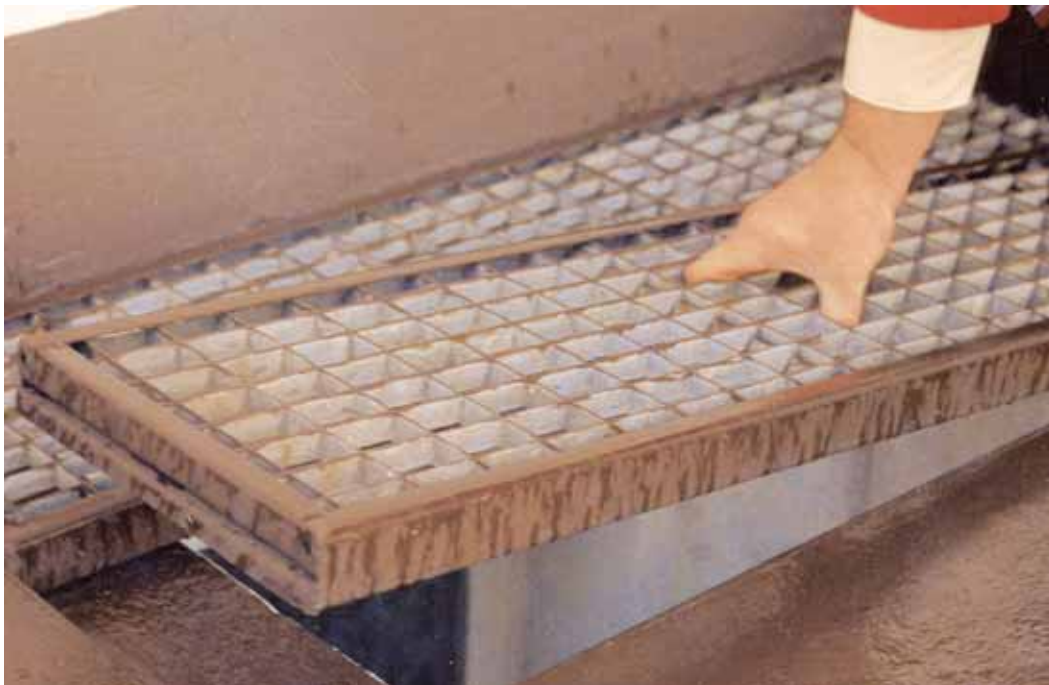
Besonders gefährdet: Verdeckte Einstiegsöffnungen, zum Beispiel Kellerfenster.
