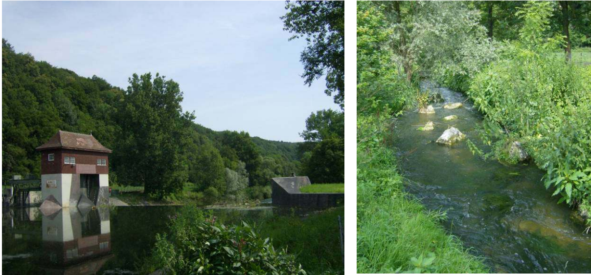
Abbildung 9: Lustnauer Wehr und Fischtreppe.
