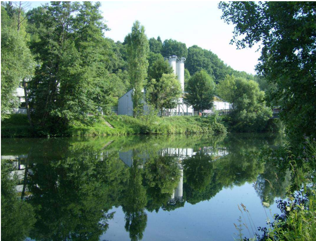
Abbildung 8: Kläranlagengebäude im Übergangsbereich vor Lustnauer Wehr.
