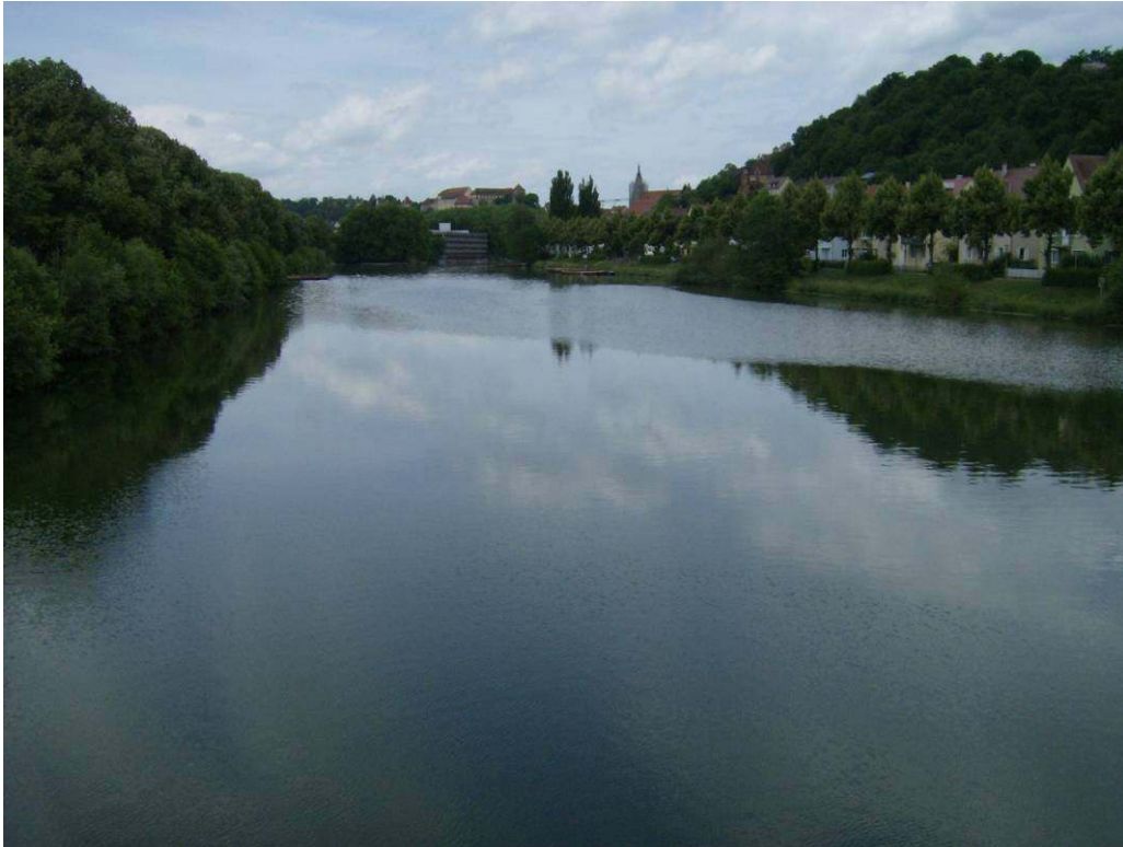
Abbildung 5: Staubereich beim Wehr Brückenstraße.
