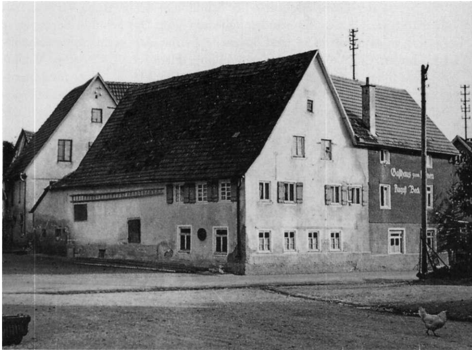
Im Bereich des Bebenhäuser Freihofs: der Gasthof zum Löwen
