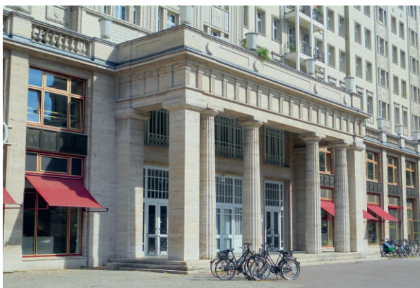
Abb. 7.11 | Richard Paulick und Kollegen: Wohnblock Nord, Stalinallee (heute: Karl-Marx-Allee), Berlin (1952/53); oben : Straßenseite 1950er Jahre; unten : Haupteingang 2022.
