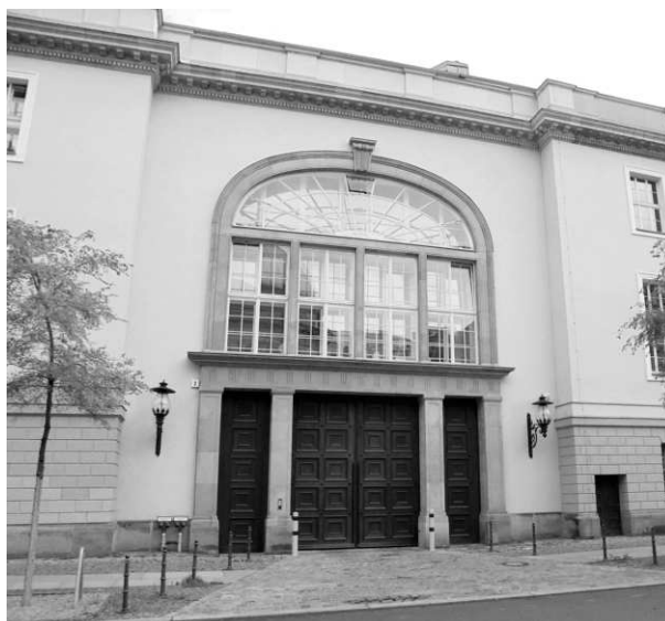
Abb. 7.10 | Richard Paulick: Verwaltungs- und Magazingebäude der Oper „Unter den Linden“, Berlin (1952–1954): Westportal in der Straße „Hinter der katholischen Kirche“.
