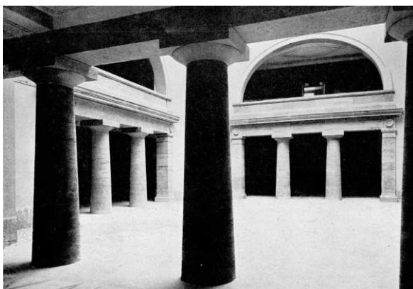
Abb. 4.5 | Friedrich Blume / Karl Janisch: Hauptverwaltung der Siemens-Schuckert-Werke, Nonnendammallee, Berlin (1912/13): Eingangshalle.
