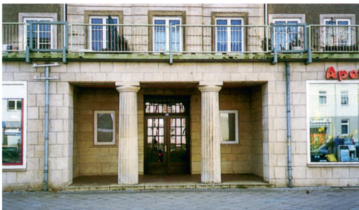
Abb. 7.12 | Willy Stamm: Geschäfts- und Wohnbebauung, Antoinettenstraße, Dessau (1954–1956): Portikus.
