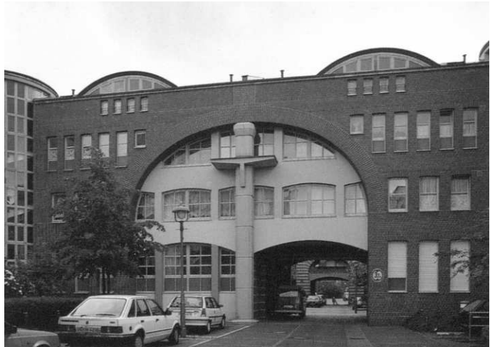
Abb. 8.27 | Rob Krier: Westblock am Schinkelplatz, Wohnanlage Ritterstraße-Nord, Berlin (1982–1987): Straßenseite.
