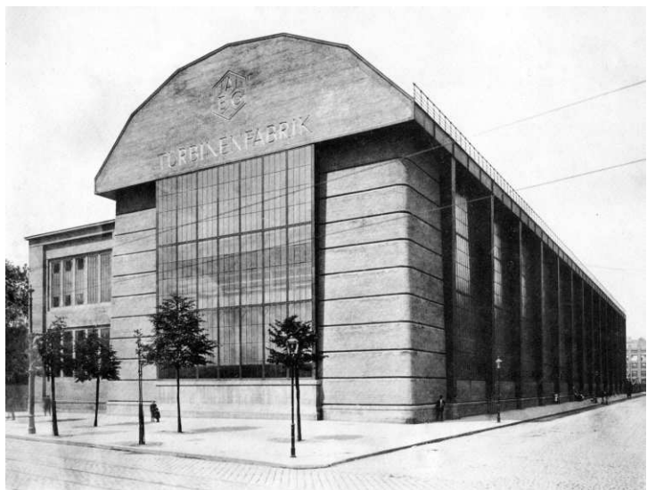
Abb. 4.17 | Peter Behrens: Turbinenhalle der AEG, Hutten-/Berlichingenstraße, Berlin (1909): Südansicht.
