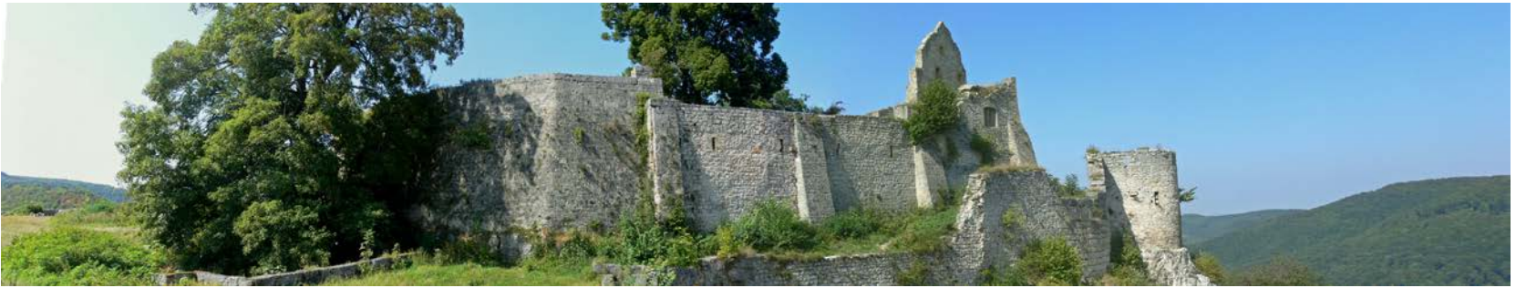
Abb. 056: Hohenurach, östliche Mauer der Kernburg.
