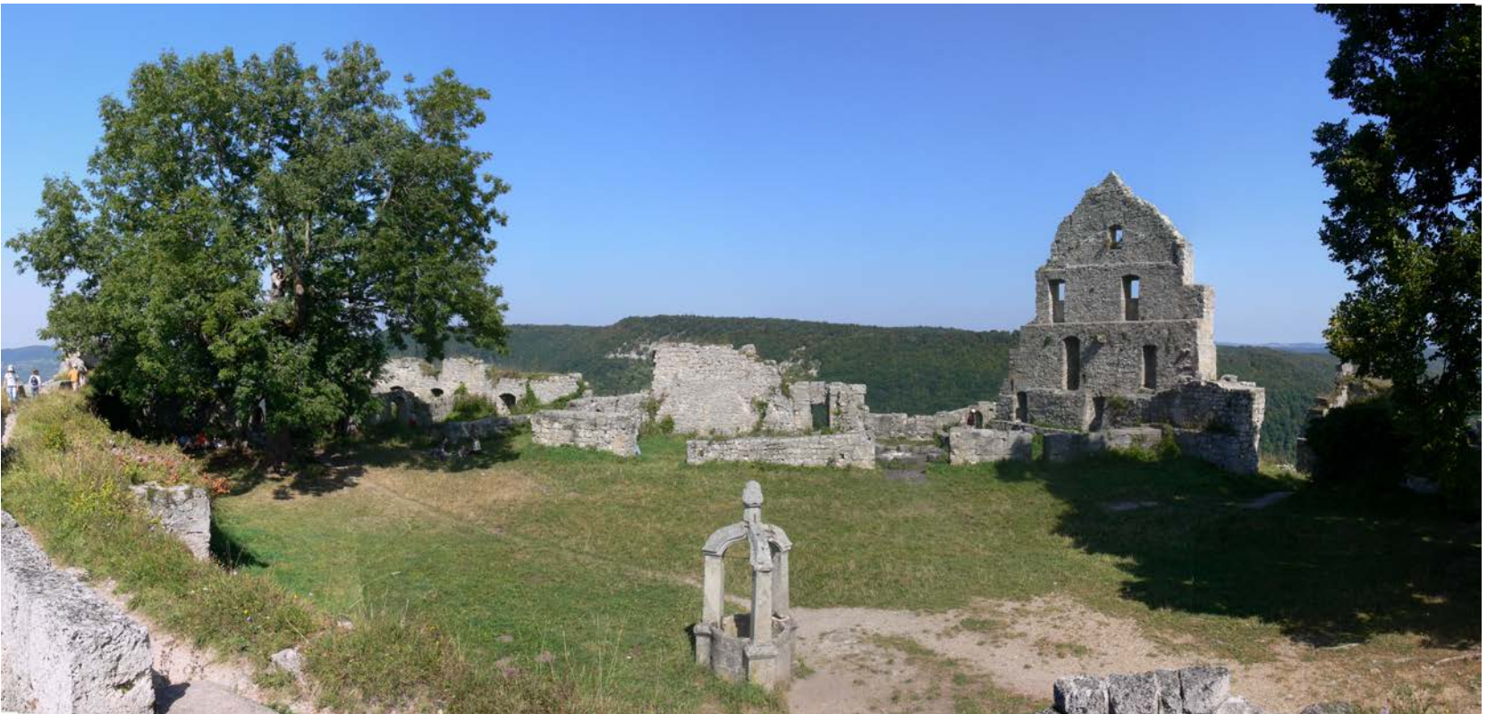
Abb. 057: Hohenurach, Innenansicht Kernburg.
