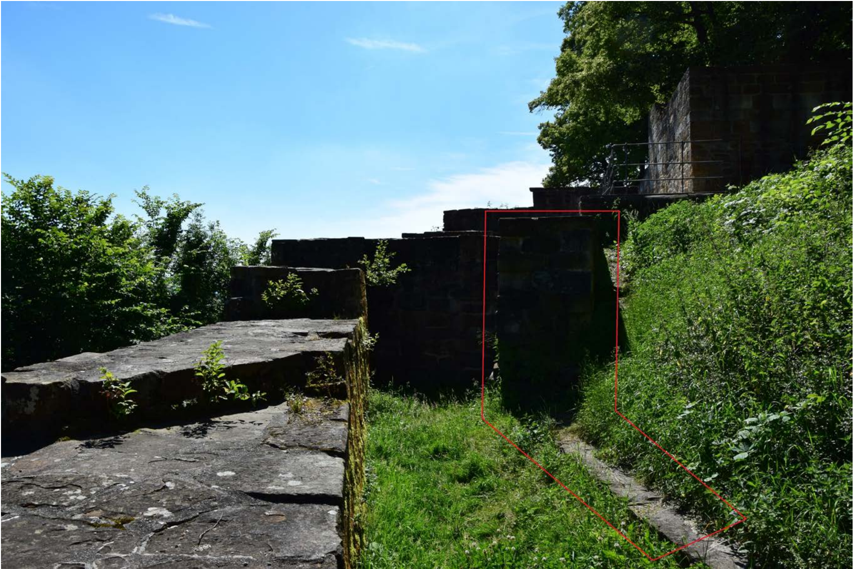
Abb. 038: Vermutlich ältester Mauerrest auf dem Hohenstaufen, südöstlich des Mannsturms.
