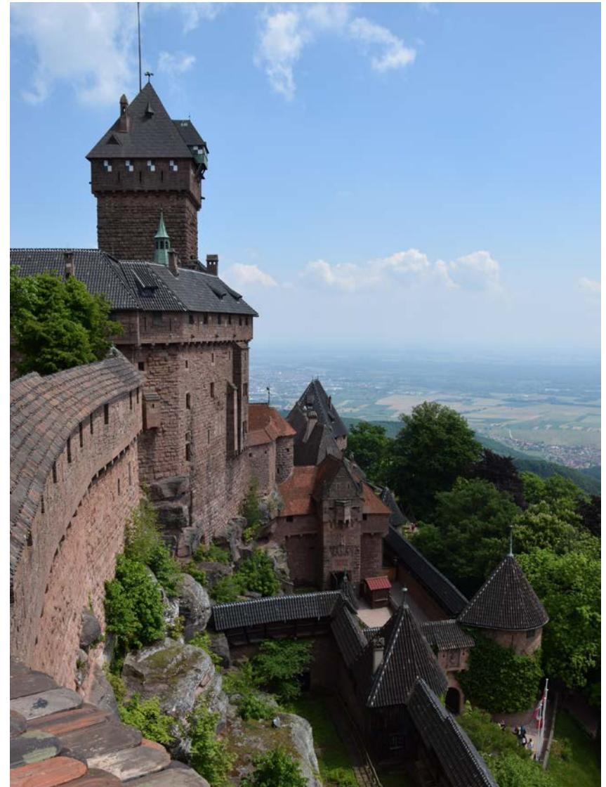
Abb. 006: Hohkönigsburg nach der Renovierung.
