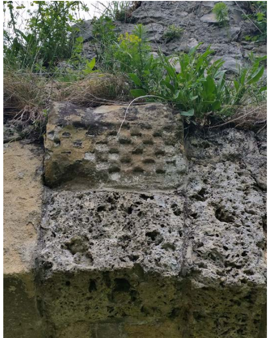
Abb. 060: Romanischer Baustein mit Schachbrettmuster, Detailansicht.
