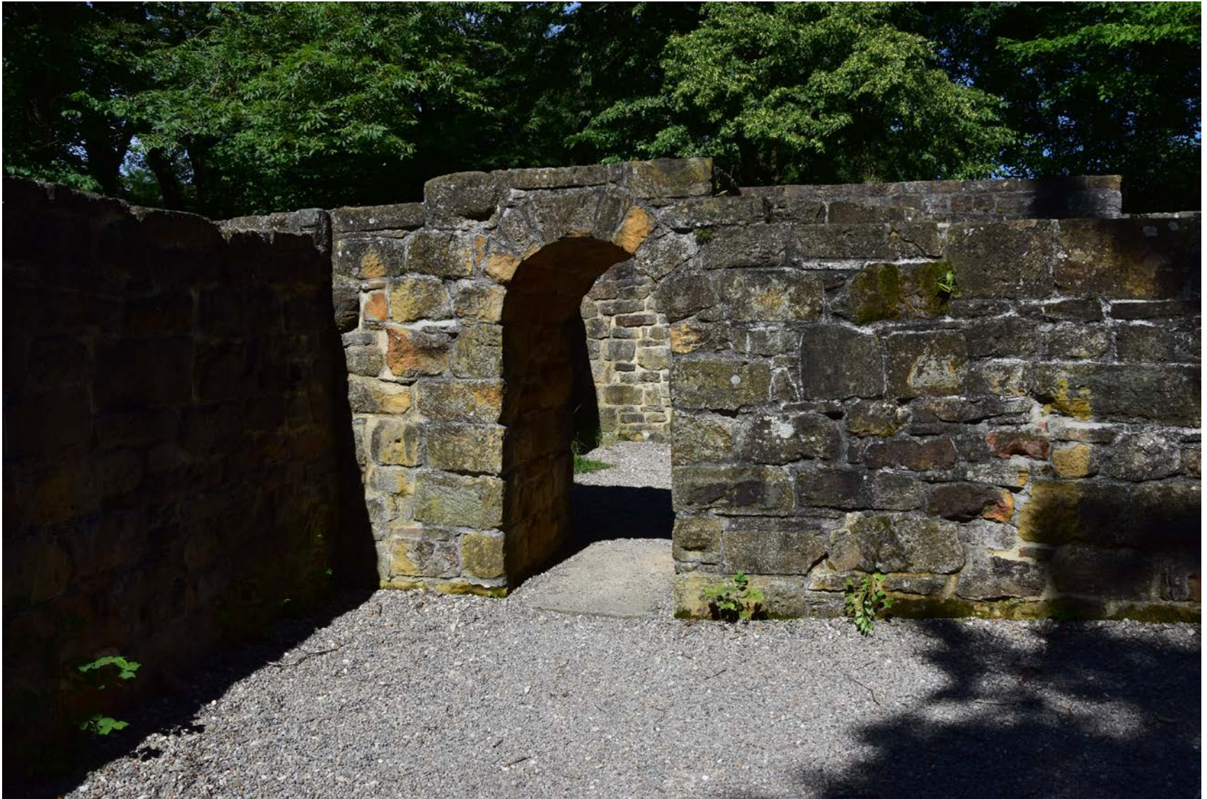
Abb. 036: Künstlich eingebrochener Durchgang im nördlichen Bereich der Trennmauer.
