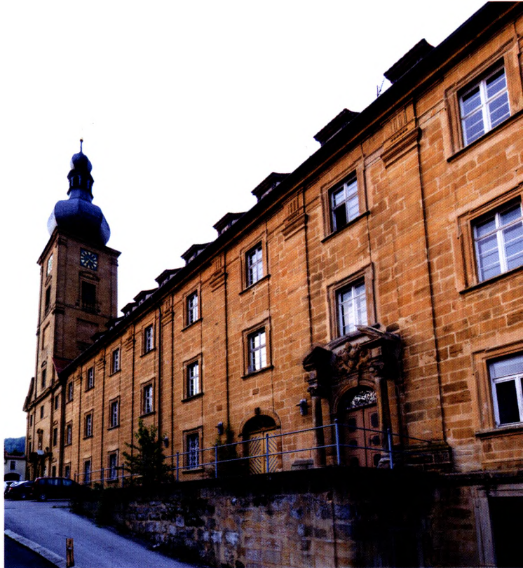
Die Westfassade des ehemaligen Klosters und der ehemaligen Klosterkirche von Weißenhohe.
