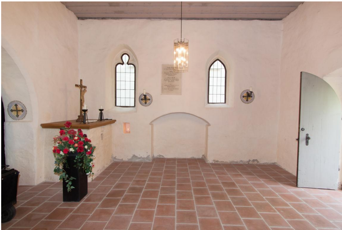
Innenansicht der Kapelle mit dem zugemauerten Südportal (Photo: Jochen Wittmann) [18]
